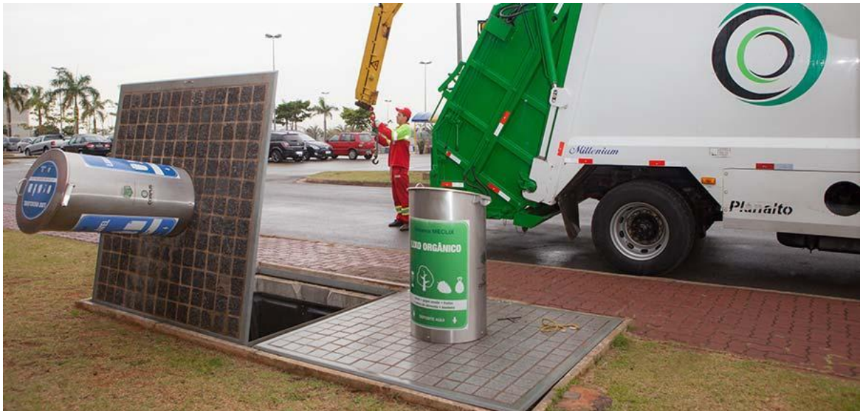
Figura 3 – Coleta de lixo urbano em reservatórios subterrâneos – Paulínea-SP
