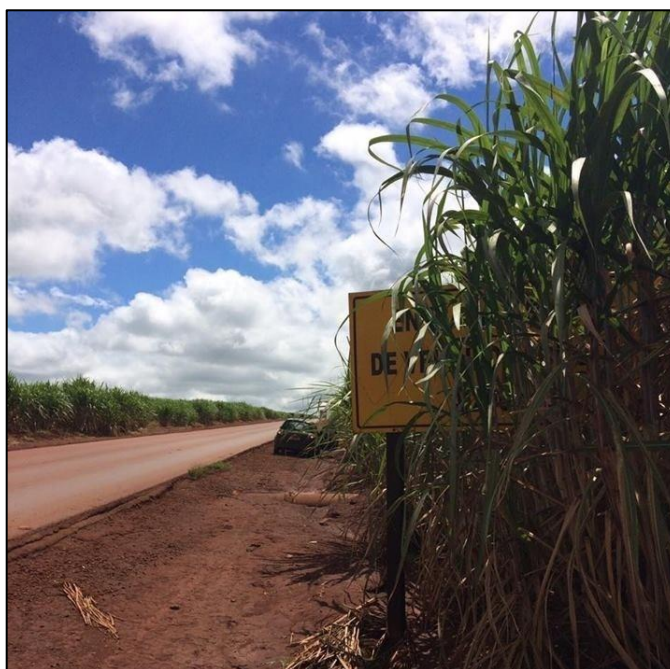
Figura 4: Placa obstruída pela vegetação Fonte: próprio autor (2017)
