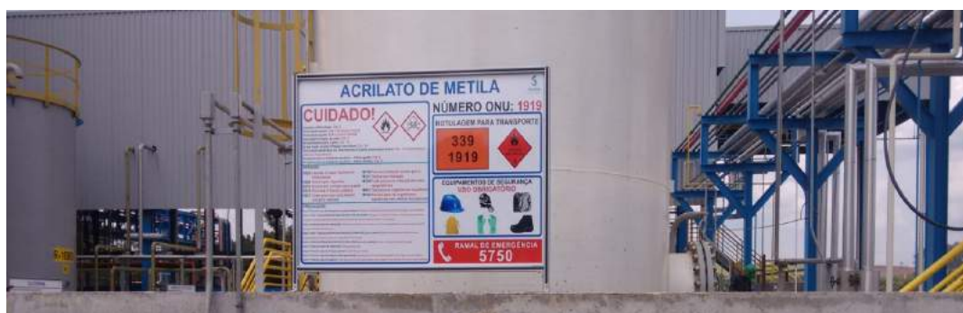
Figura 5.2.3 Tanque de produto perigoso
