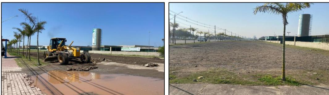
*Fotos: Área utilizada como estacionamento externo antes e depois da colocação de cascalho e aplainamento para evitar a formação de poças e lama, facilitando o estacionamento e locomoção de estudantes neste local.*
