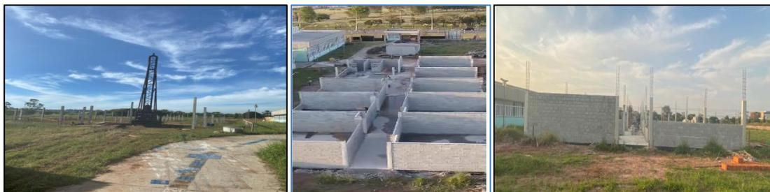
*Fotos: Construção de um novo bloco de salas de aulas e sala dos professores. Sendo a primeira foto a colocação de estacas para a edificação e as duas outras do estado da construção em agosto deste ano.*
