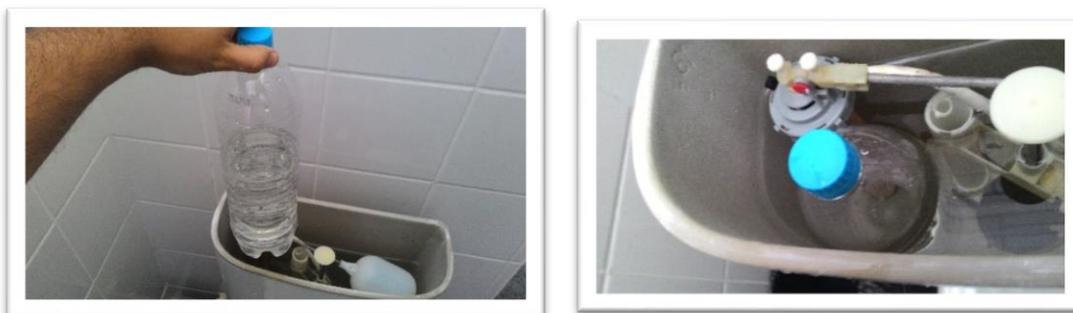
**Figura 7.** Colocação de garrafas de 1,5 litros nas caixas de descarga.
